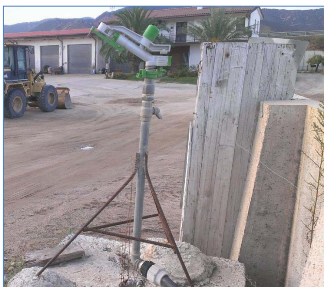
Figura 11 - Nebulizzatori installati lungo il perimetro
