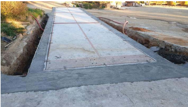
Figura 7 - Pesa a ponte in fase di installazione
